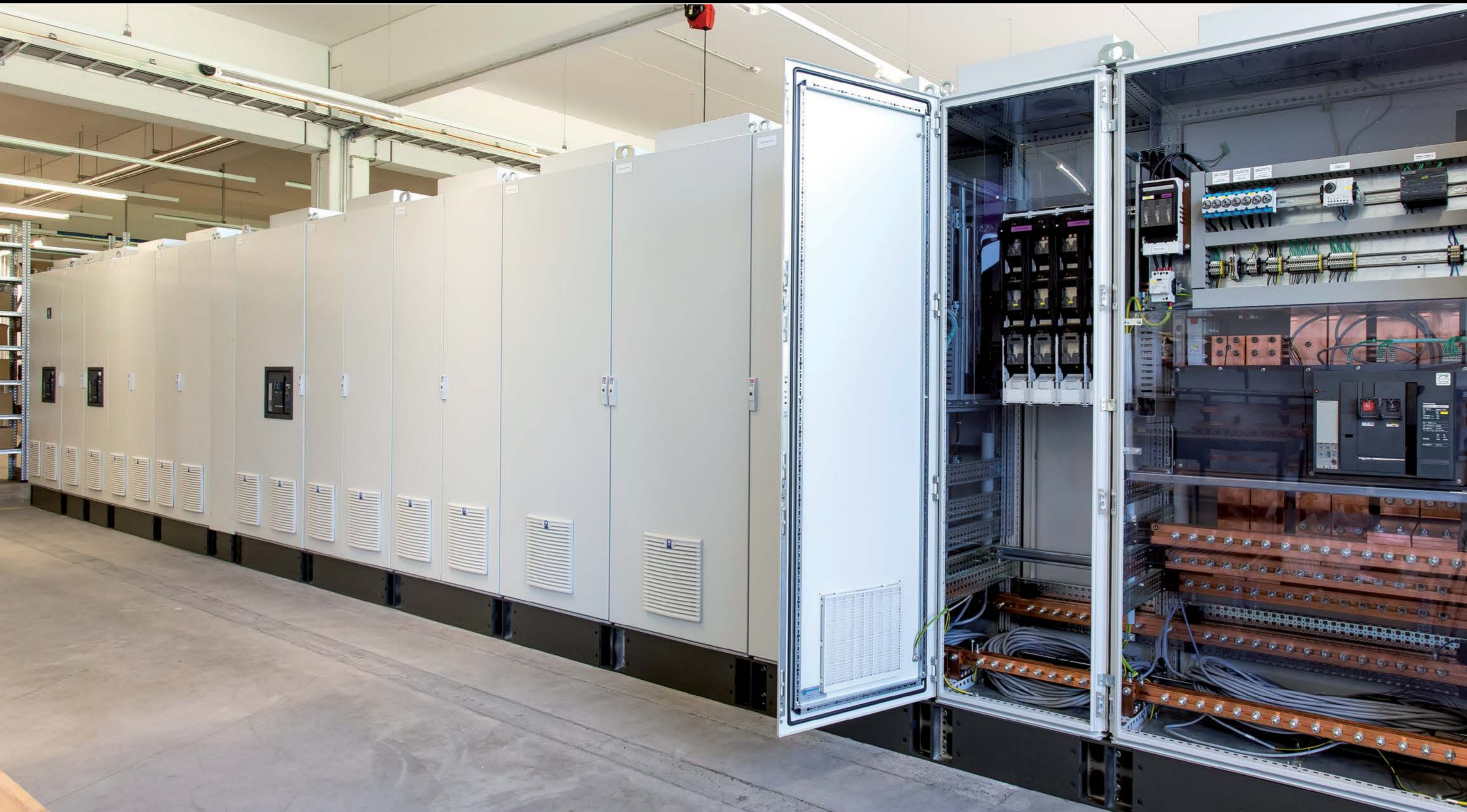
Günter Hinterberger macht's möglich: Niederspannungsschaltanlage mit 27.000 A
