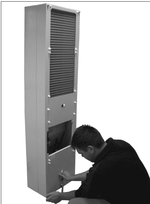
Abb. 77: Vier Schrauben der Haube lösen
