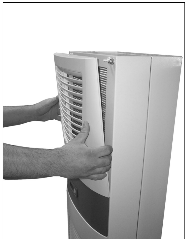
Abb. 42: Oberes Lamellengitter entfernen
