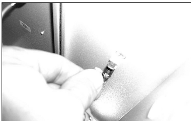
Obr. 76: Vytažení uzemňovacího kabelu ventilátoru (2)
