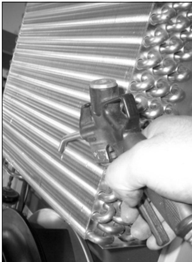
Obr. 82: Registr výměníku tepla a prostor kompresoru vyfoukat stlačeným vzduchem (2)
