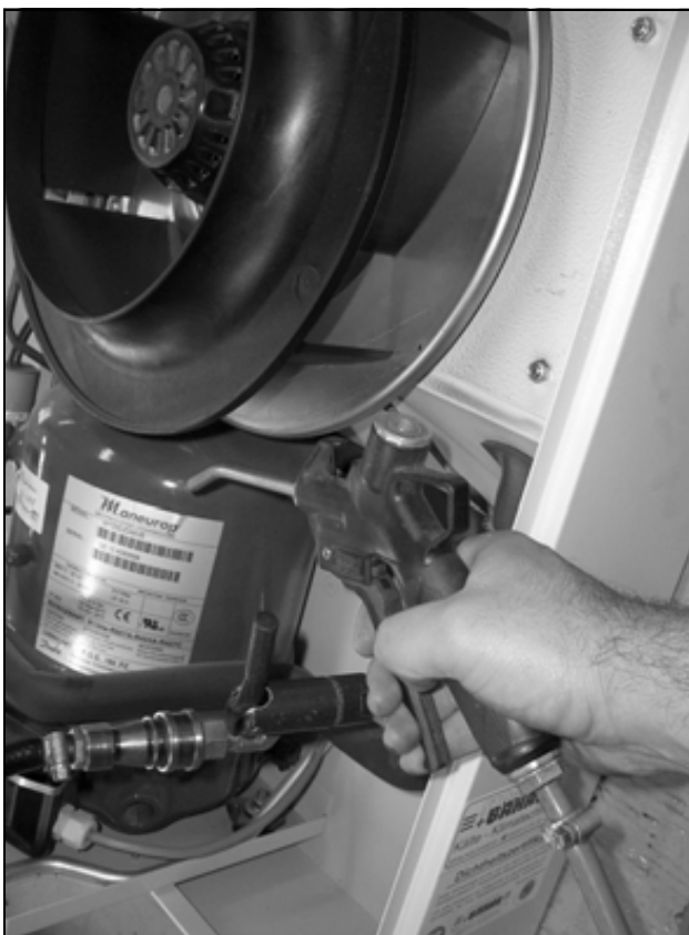
Obr. 59: Registr výměníku tepla a prostor kompresoru vyfoukat stlačeným vzduchem (2)
