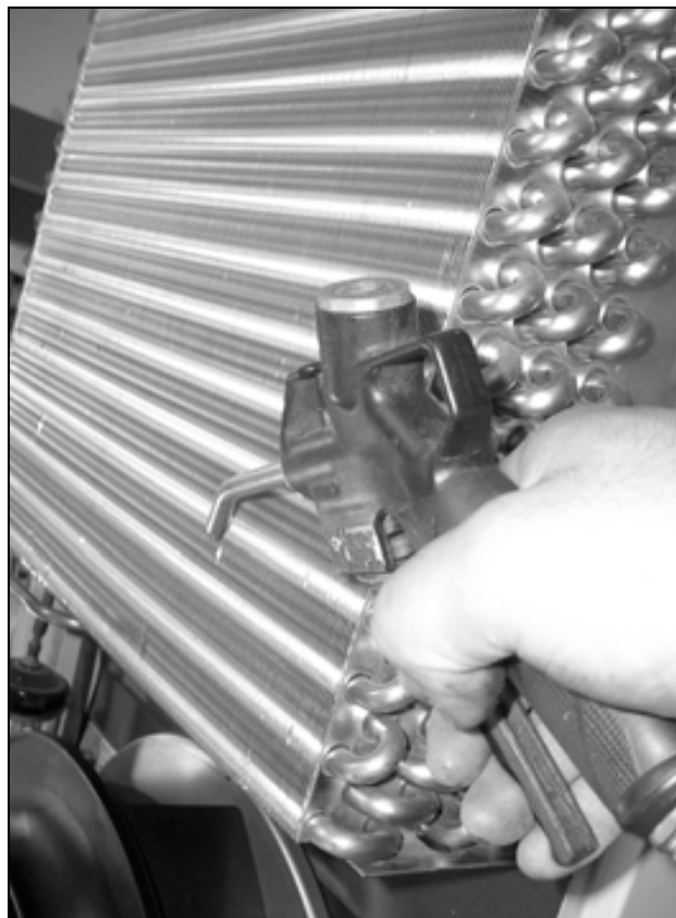
Obr. 58: Registr výměníku tepla a prostor kompresoru vyfoukat stlačeným vzduchem (1)
