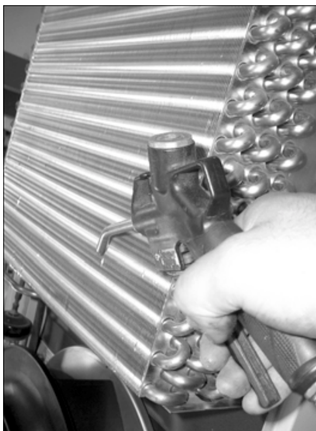
Fig. 58: Varmevexlerenhed og kompressorkammer rengøres med trykluft (1)
