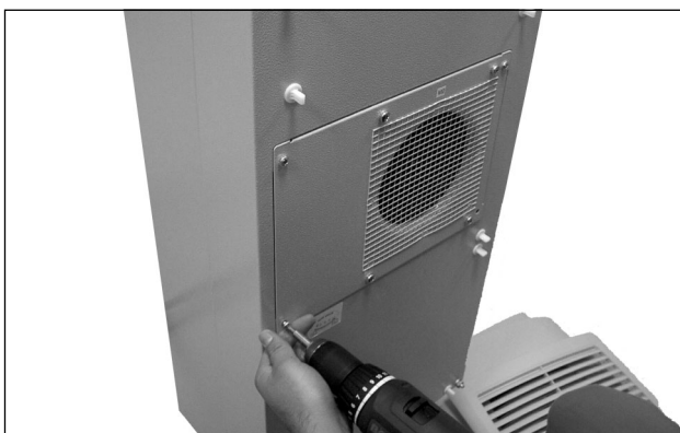
Fig. 70: De fire skruer til det eksterne kredsløbs ventilator løsnes
