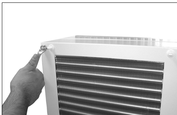
Fig. 51: Kappen afmonteres (fire skruer løsnes)
