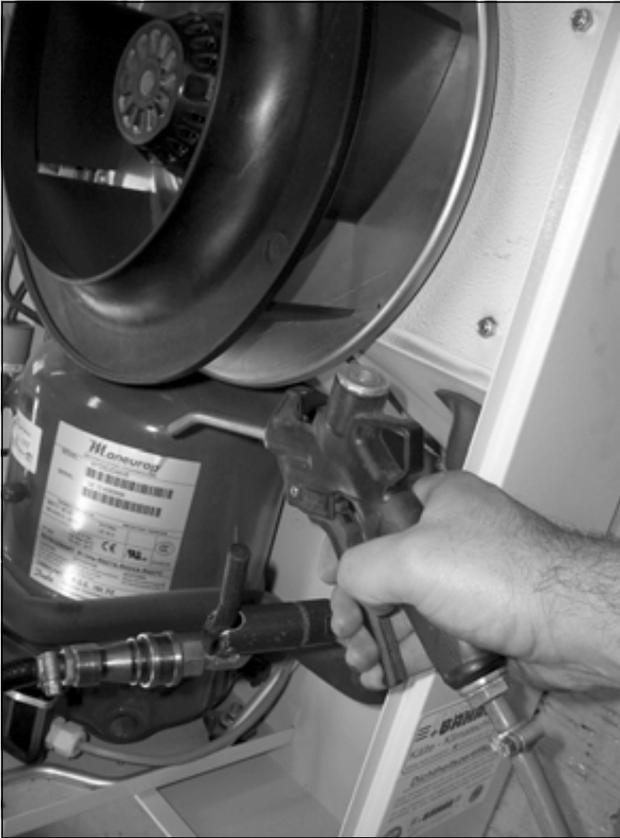
Imagen 59: Aplicar aire a presión en el registro del intercambiador de calor y el espacio del compresor (2)
