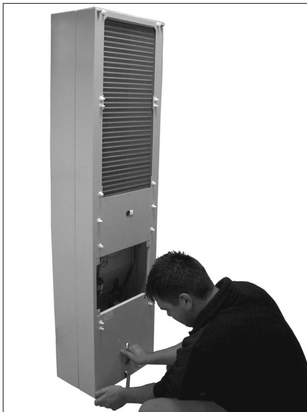
Imagen 77: Extraer los cuatro tornillos de la cubierta
