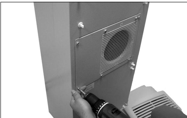
Imagen 70: Extraer los cuatro tornillos del ventilador del circuito exterior
