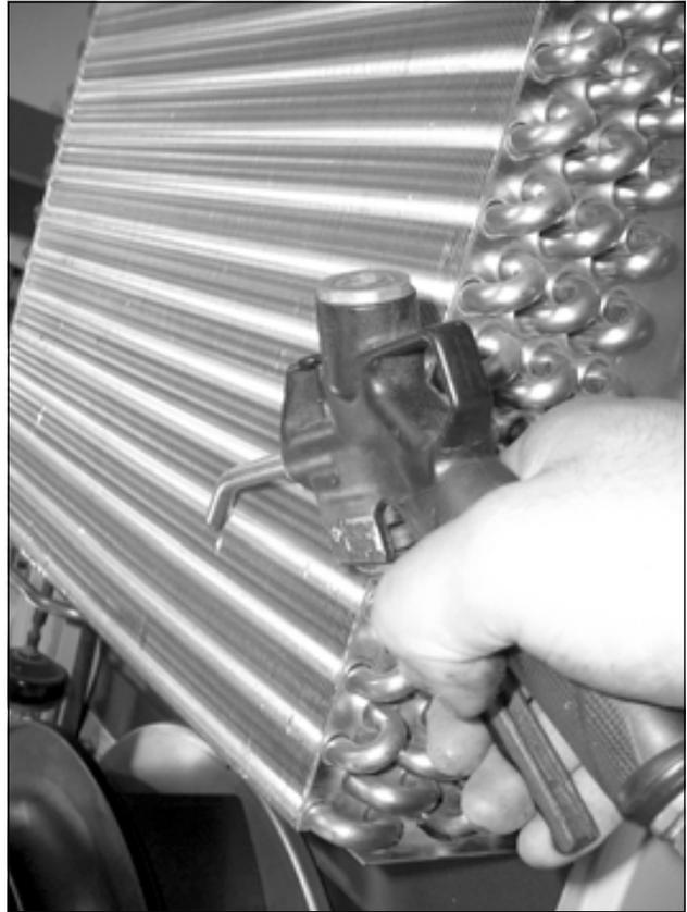
Imagen 82: Aplicar aire a presión en el registro del intercambiador de calor y el espacio del compresor (2)
