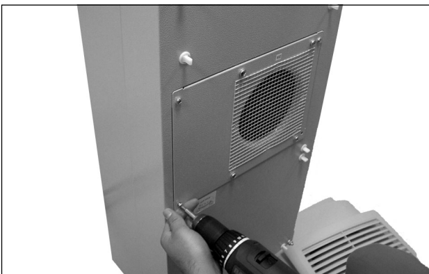
Fig. 70 : Dévisser les quatre vis du ventilateur du circuit externe
