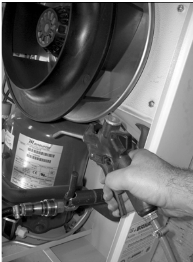
Fig. 59 : Nettoyer l'unité d'échange thermique et l'espace compresseur à l'air comprimé (2)
