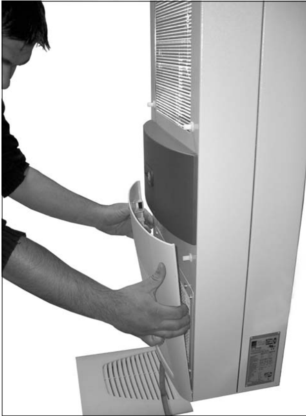
図 43： 下のプラスチックバーを取外す
