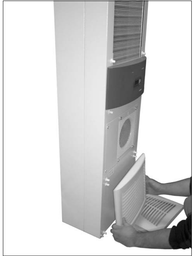
図 65： 下のプラスチックルーバーを取外す (2)
