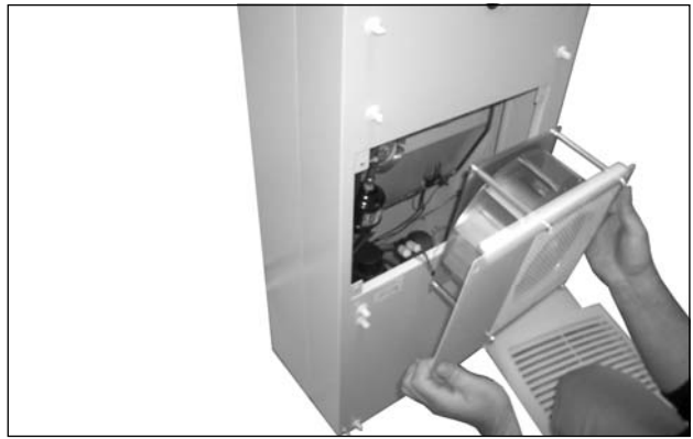
図 71： 外部循環経路用のファンを取外す
