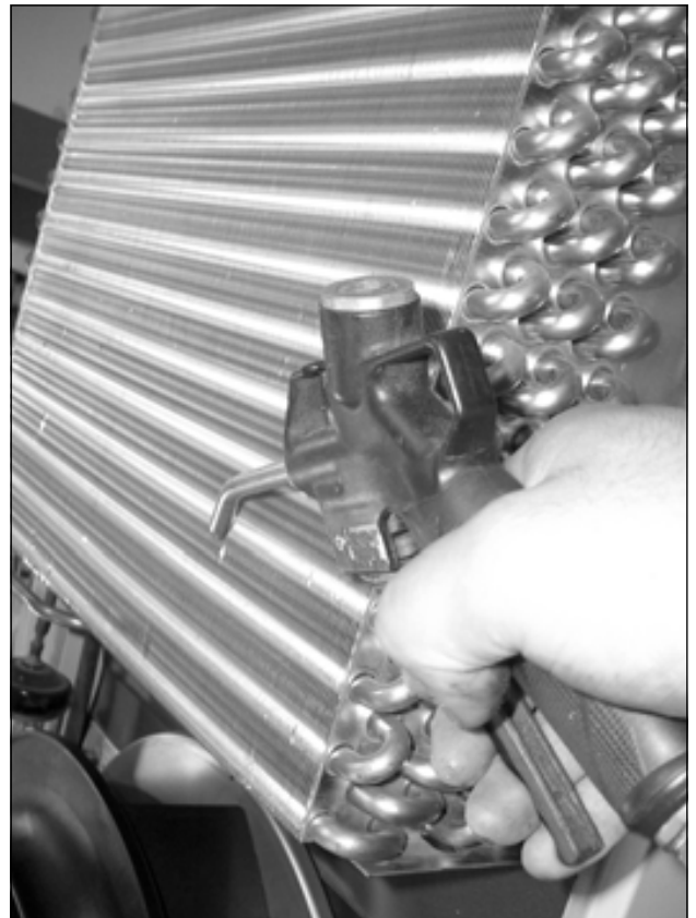
図 58： ヒートエクスチェンジャー部分とコンプレッサールームの汚れを圧縮空気で吹き払う (1)
