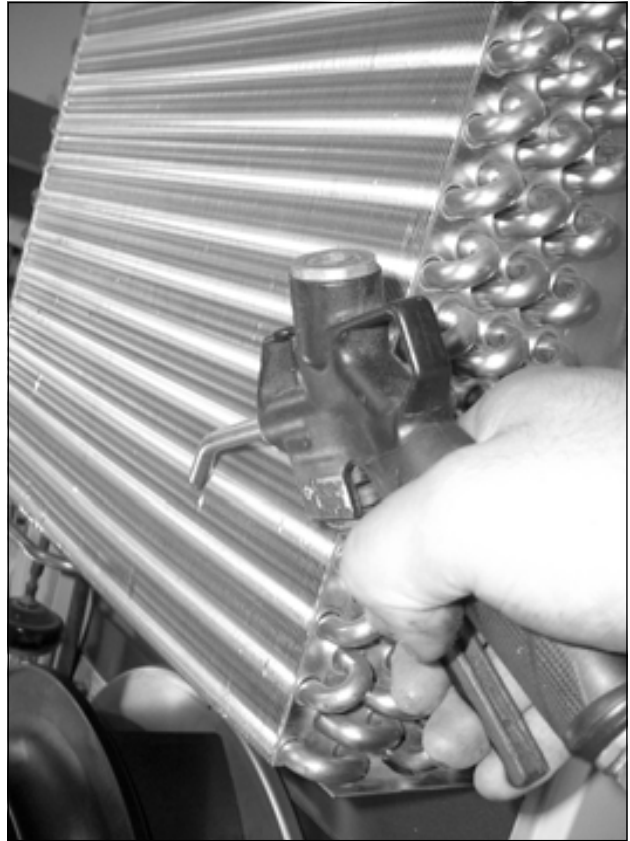
図 82： ヒートエクスチェンジャー部分とコンプレッサールームの汚れを圧縮空気で吹き払う (2)
