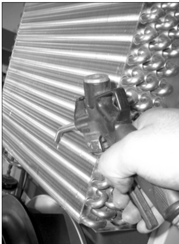
Afb. 82: Warmtewisselaarregister en compressorruimte met perslucht doorblazen (2)
