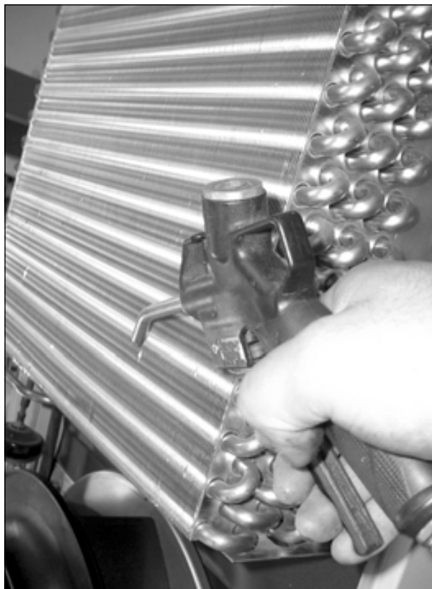
Afb. 58: Warmtewisselaarregister en compressorruimte met perslucht doorblazen (1)
