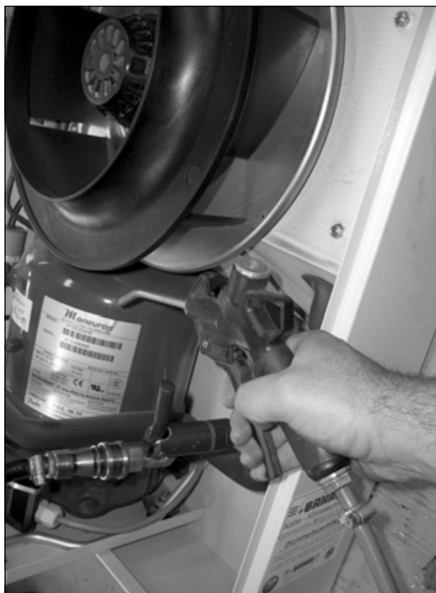
Afb. 83: Warmtewisselaarregister en compressorruimte met perslucht doorblazen (3)
