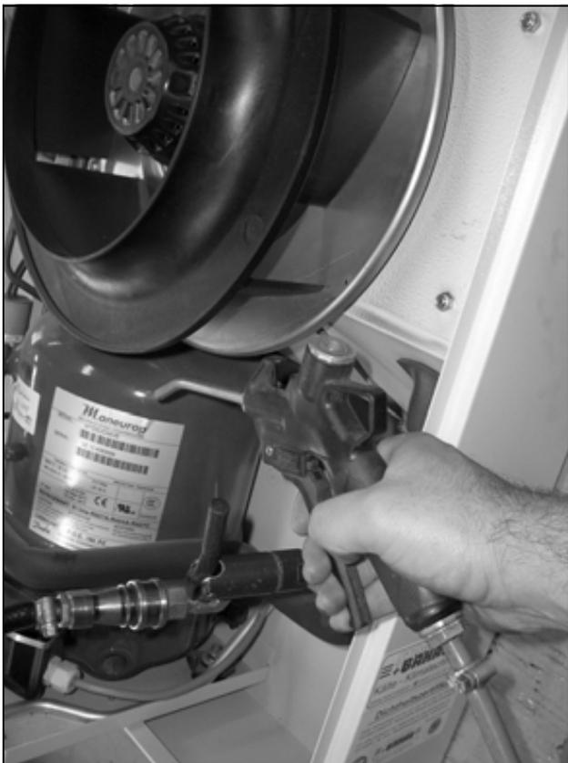
Рис. 59: Продувка теплообменного элемента и компрессорного отделения сжатым воздухом (2)
