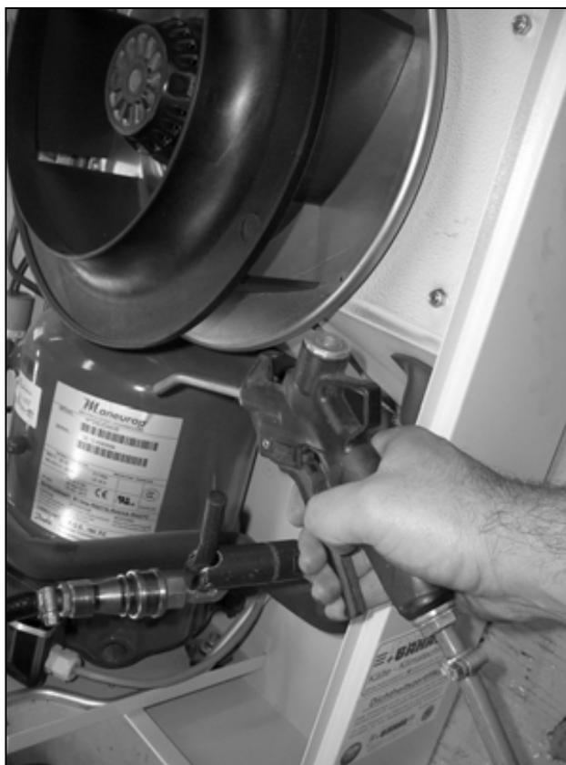
Рис. 83: Продувка теплообменного элемента и компрессорного отделения сжатым воздухом (3)
