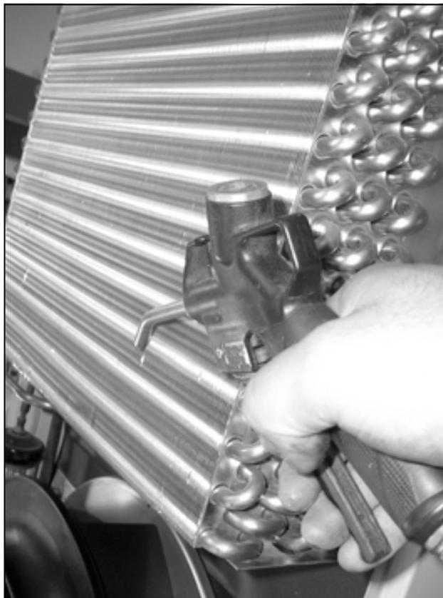
Рис. 82: Продувка теплообменного элемента и компрессорного отделения сжатым воздухом (2)
