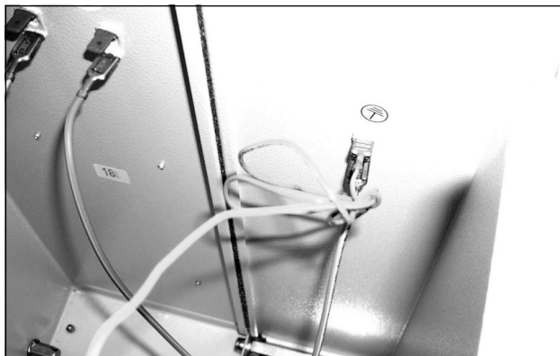
Bild 75: Koppla från fläktens jordningskabel (1)
