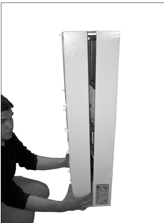
Bild 55: Ta bort kåpan (2)
