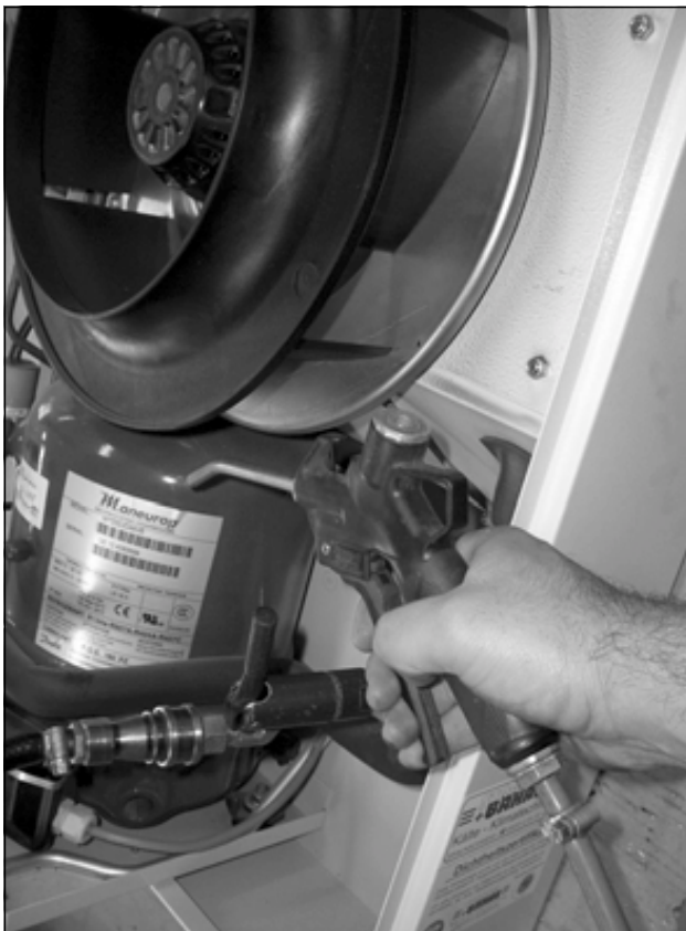
Bild 59: Rengör värmväxelpaketet och kompressorrum med tryckluft (2)
