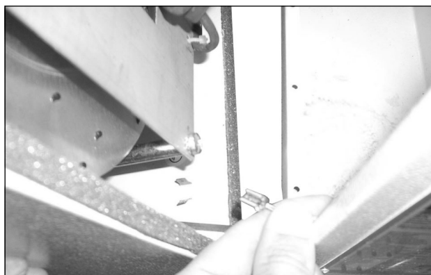
Bild 57: Lossa på jordningskabel mellan kåpa och chassi (2)
