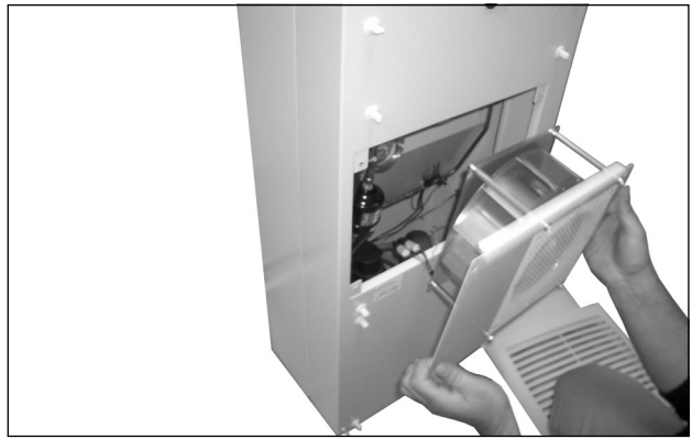
Bild 71: Demontera det yttre kretsloppets fläkt
