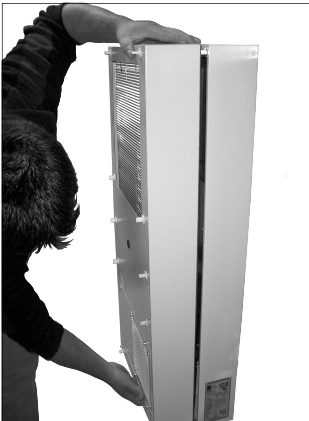
Bild 54: Ta bort kåpan (1)
