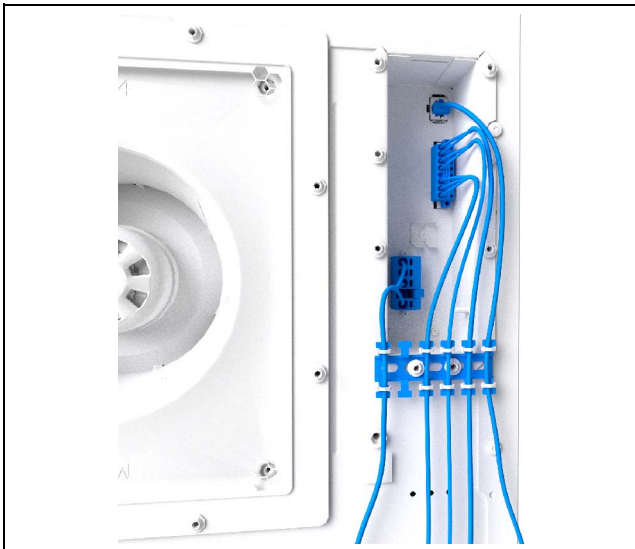
Rys. 20: Wykonanie odciążenia za pomocą opasek (przykładowa ilustracja)
