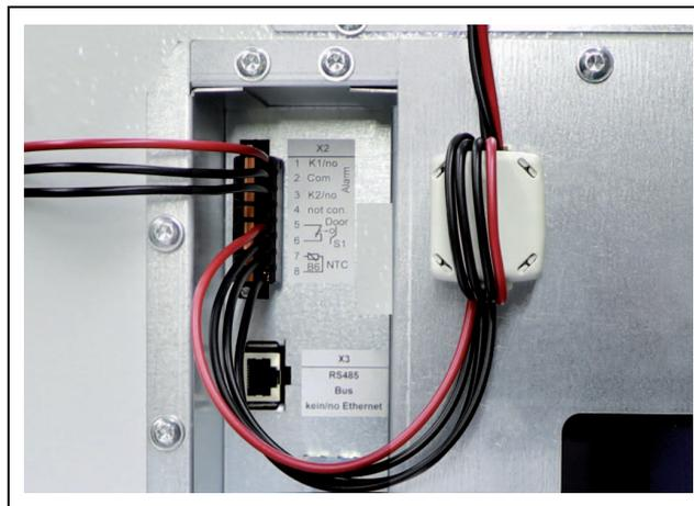
Imagen 14: Cable de señal con núcleo de ferrita montado
