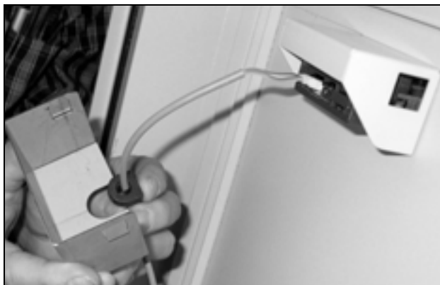
Obr. 16: Zasunutí kabelové průchodky
