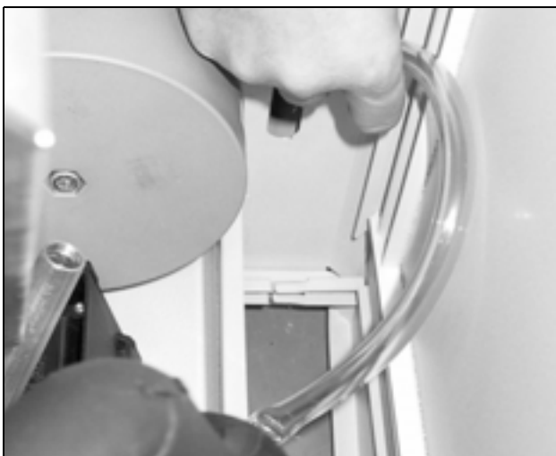
Obr. 9: Vyvedení odtoku kondenzátu ze zařízení
