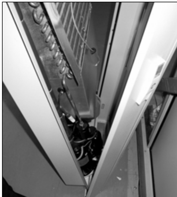
Obr. 8: Montáž chladicího modulu do profilových dveří
