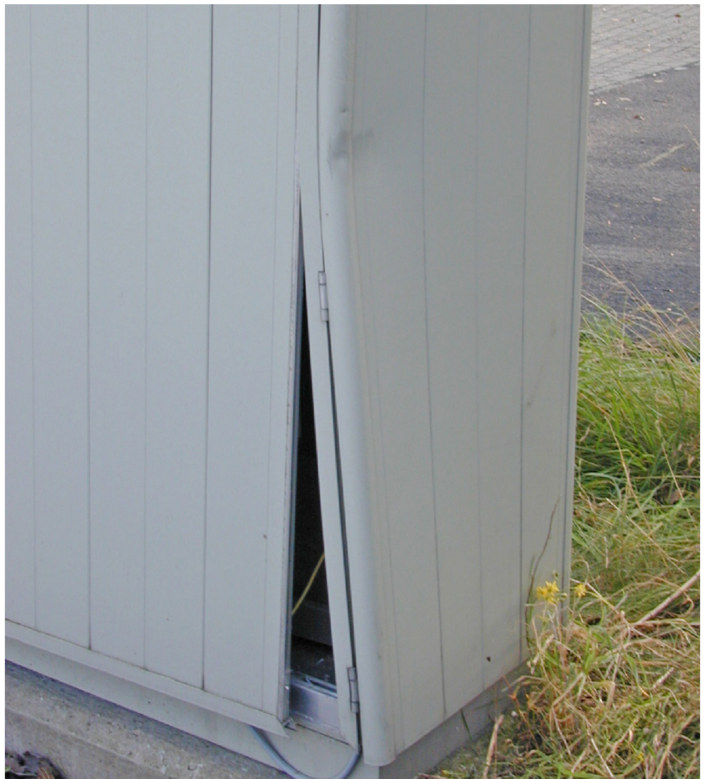
示图 1：碰撞后变形的机柜
