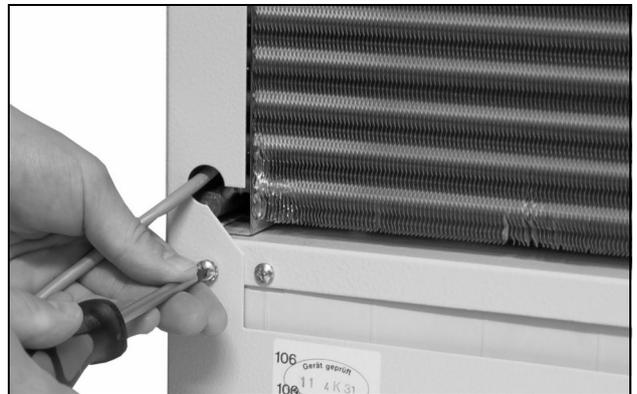
Abb. 28: Befestigungsschrauben der Haube entfernen (vier Schrauben lösen)
