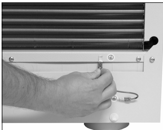
Imagen 27: Desconectar el cable de puesta a tierra
