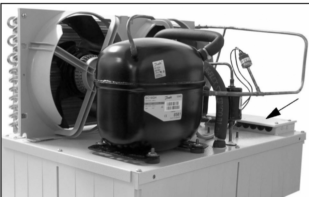
Afb. 31: Koelaggregaat zonder afdekkap (achteraanzicht)
