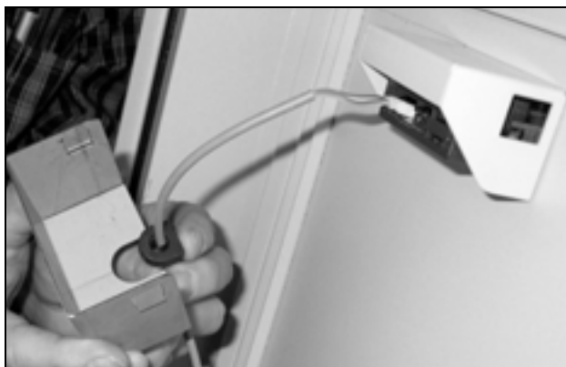
Imagen 16: Introducir la boquilla para cables
