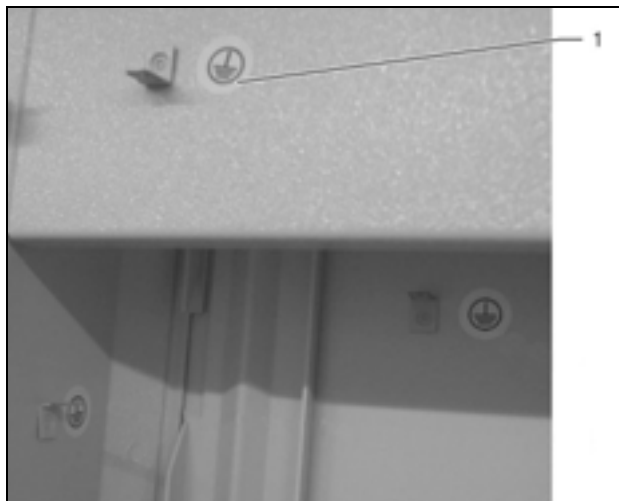
Fig. 13 : Points de raccordement pour câbles de mise à la masse
