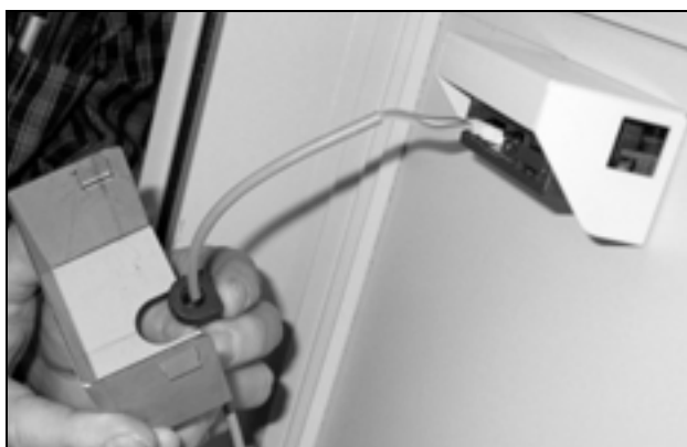
Fig. 16 : Insérer le joint passe-câble
