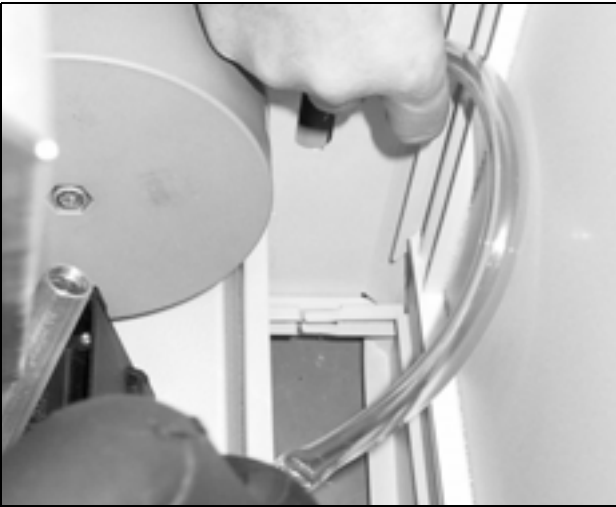
Kuva 9: Kondenssivesiletkun vetäminen ulos laitteesta
