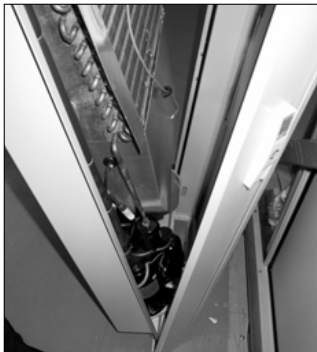
Kuva 8: Jäähdytinmoduulin asennus profiilioveen
