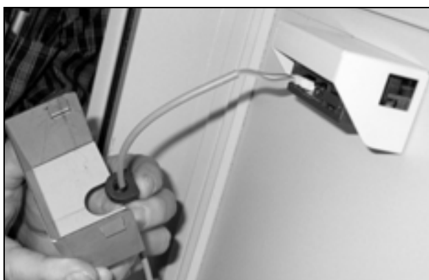
Kuva 16: Lämpivientitiiviteen asennus
