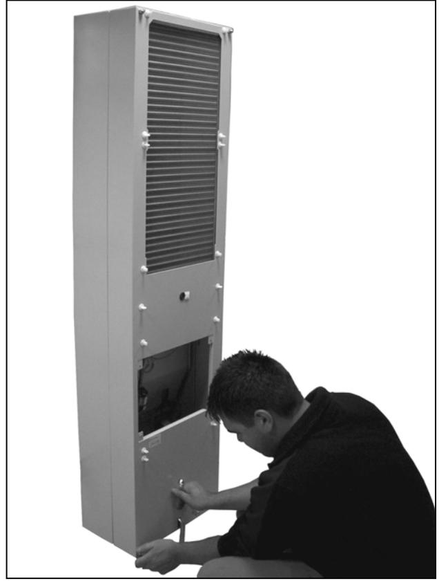
Abb. 70: Vier Muttern der Haube lösen
