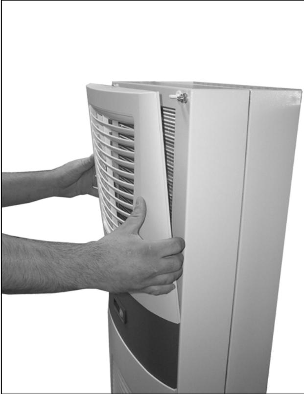
Abb. 35: Oberes Lamellengitter entfernen
