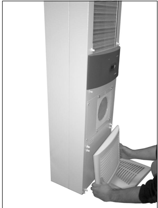
Abb. 58: Unteres Lamellengitter entfernen (2)
