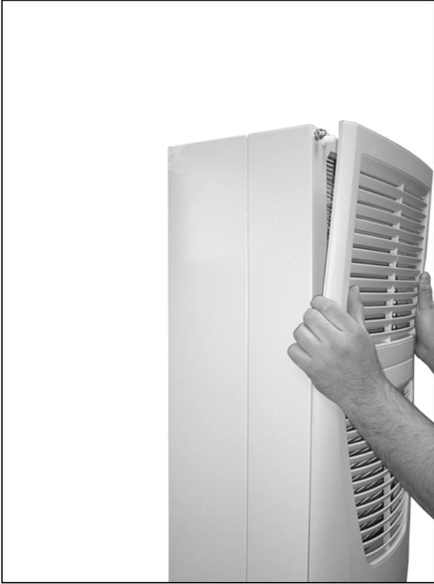
Abb. 55: Oberes Lamellengitter entfernen (2)
