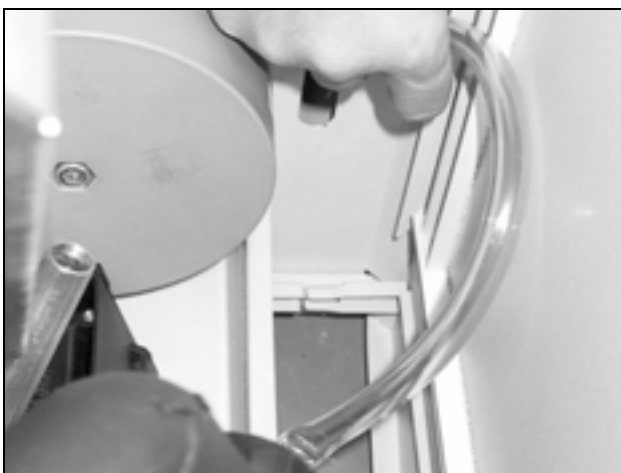
Fig. 9: Estrazione del tubo di scarico della condensa
