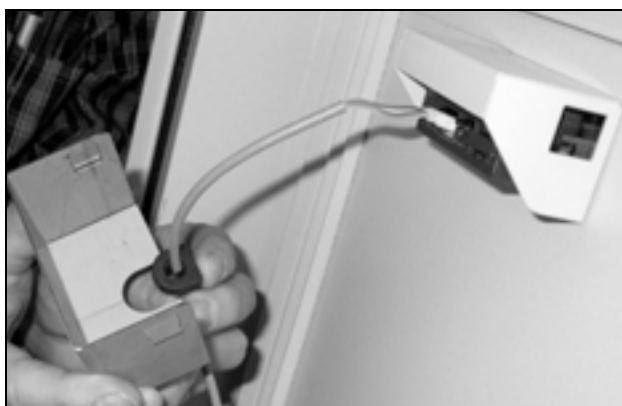
Fig. 16: Introduzione della guaina del cavo
