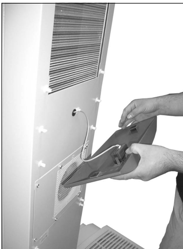
Fig. 59 : retirer le plastron
