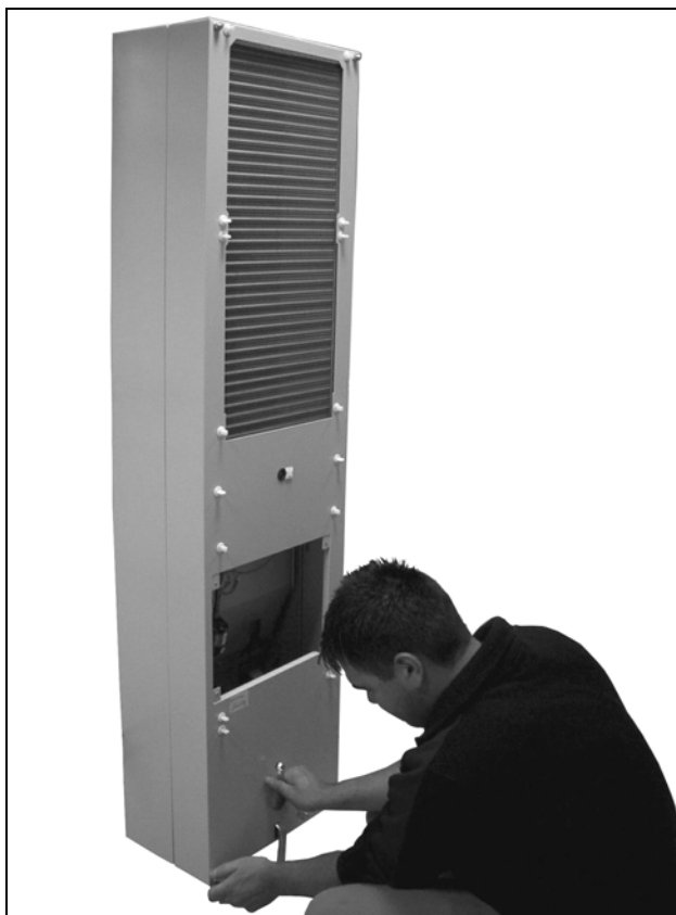
Fig. 70 : dévisser les 4 écrous du capot
