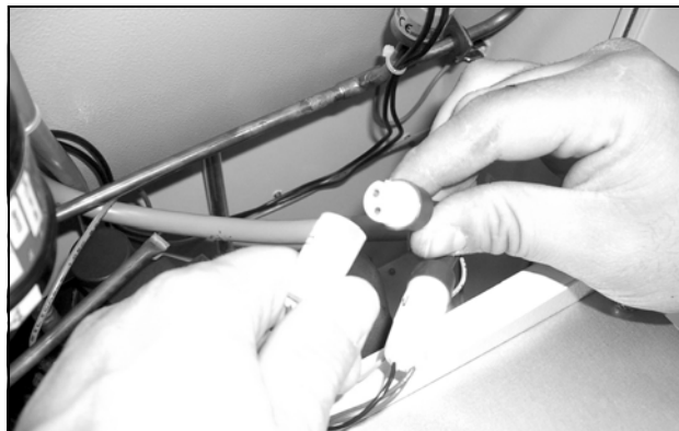
Fig. 67 : débrancher les fiches de raccordement du ventilateur (3)
