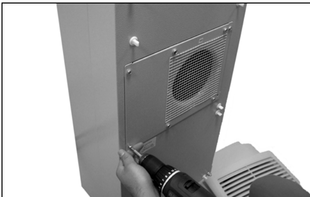
Fig. 63 : dévisser les quatre vis du ventilateur du circuit externe
