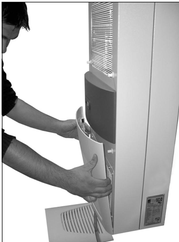
Fig. 36: Rimuovere la griglia di aerazione inferiore
