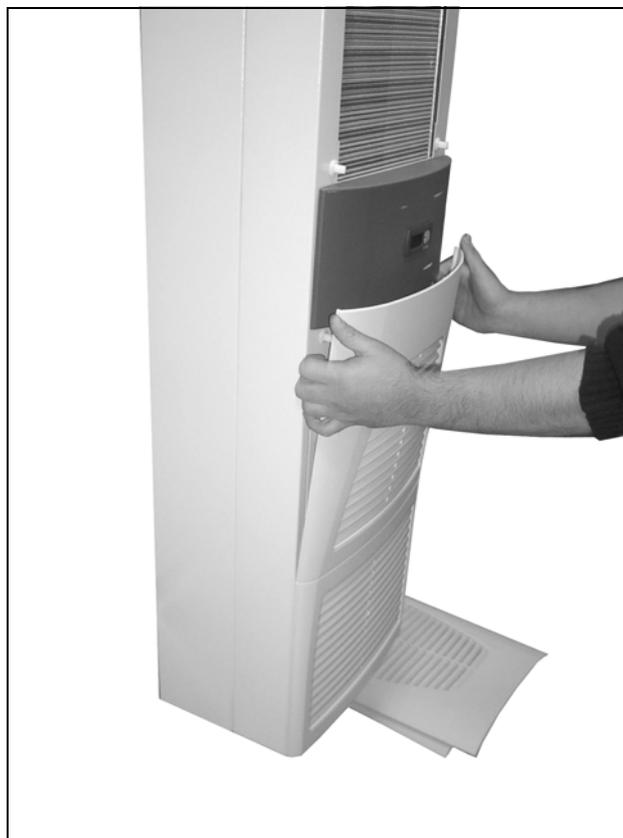
Fig. 57: Rimuovere la griglia di aerazione inferiore (1)
