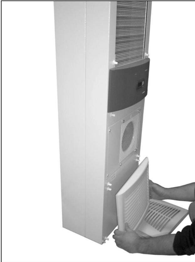
Fig. 58: Rimuovere la griglia di aerazione inferiore (2)
