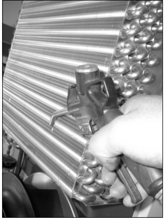
75. ábra: Fúvassa ki a hőcserélőt és a kompresszorteret sűrített levegővel (2)
