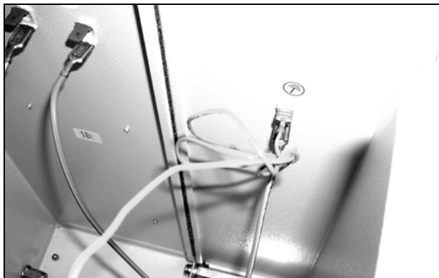
68. ábra: Húzza ki a ventilátor földelőkábelét (1)
