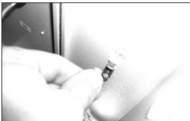
69. ábra: Húzza ki a ventilátor földelőkábelét (2)
