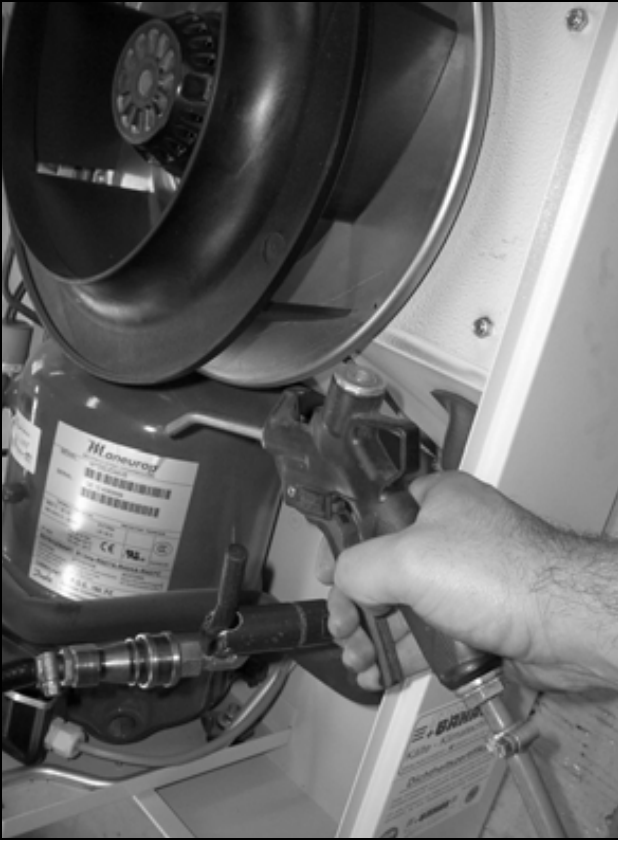
52. ábra: Fúvassa ki a hőcserélőt és a kompresszorteret sűrített levegővel (2)
