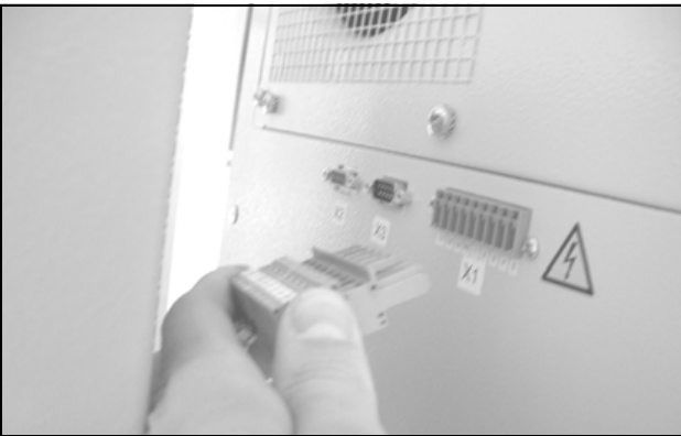
53. ábra: Húzza ki a hálózati csatlakozót
