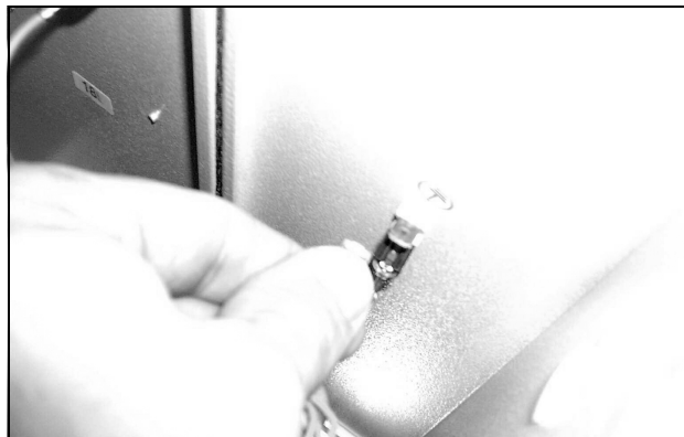
Obr. 69: Odpojenie zemniaceho kábla ventilátora (2)
