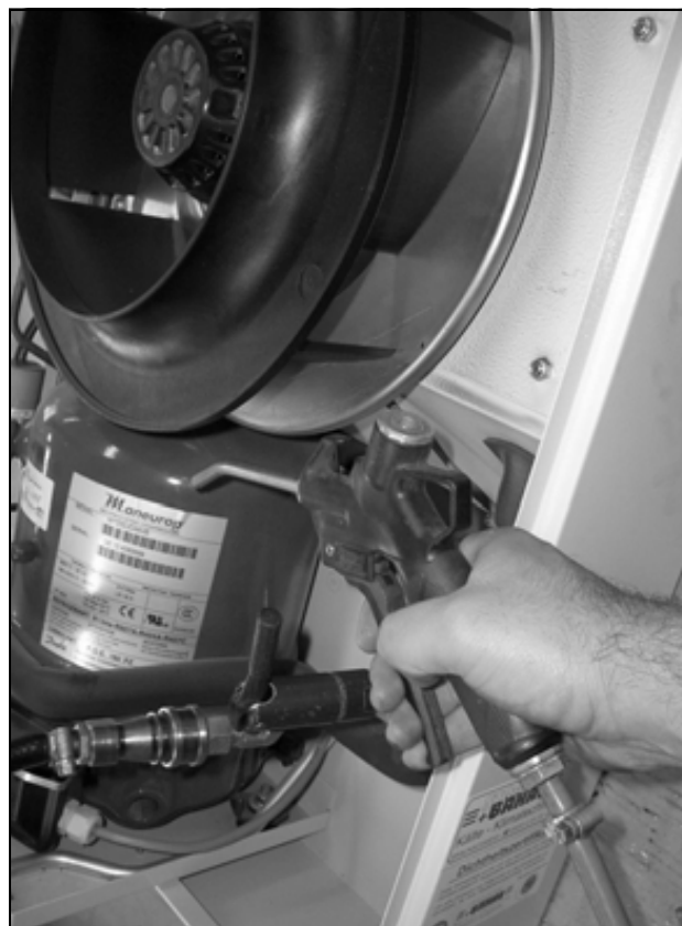
Obr. 52: Vyfúkanie telesa výmenníka tepla a priestoru kompresora stlačeným vzduchom (2)
