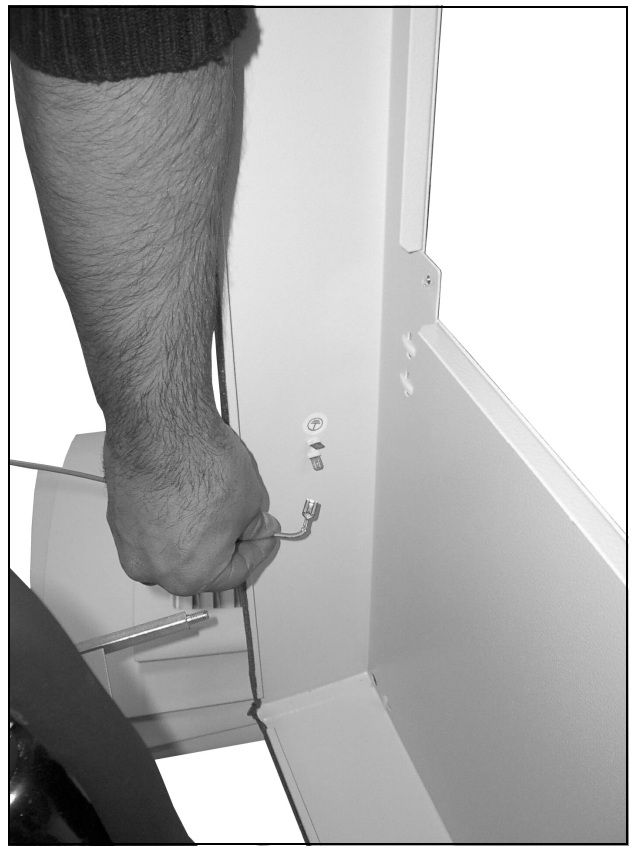
Obr. 73: Odpojenie zemniaceho kábla (2)
