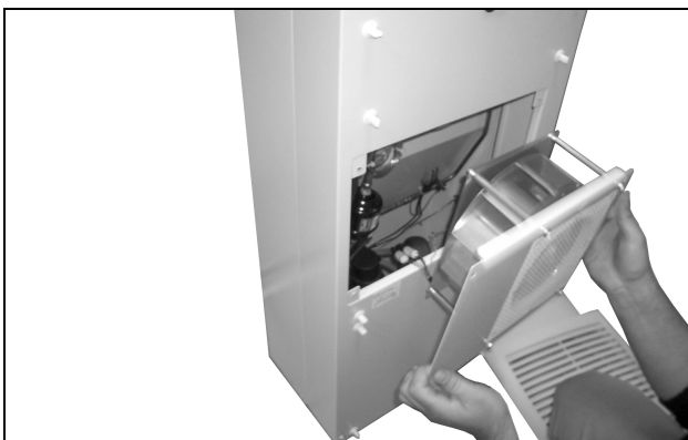
Obr. 64: Demontáž ventilátora vonkajšieho okruhu
