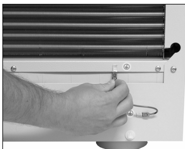
Rys. 27: Wyciąganie kabla uziemienia
