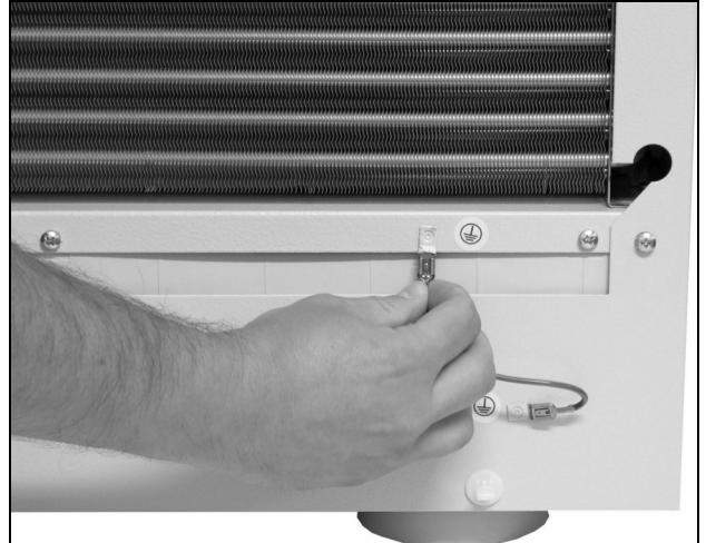
Bild 27: Dra ut jordningskabel
