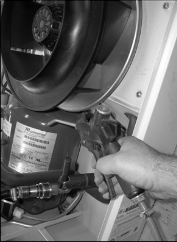
Şek. 52: Isı eşanjörü devresi ve kompresör odasını basınçlı hava ile temizleyin (2)
