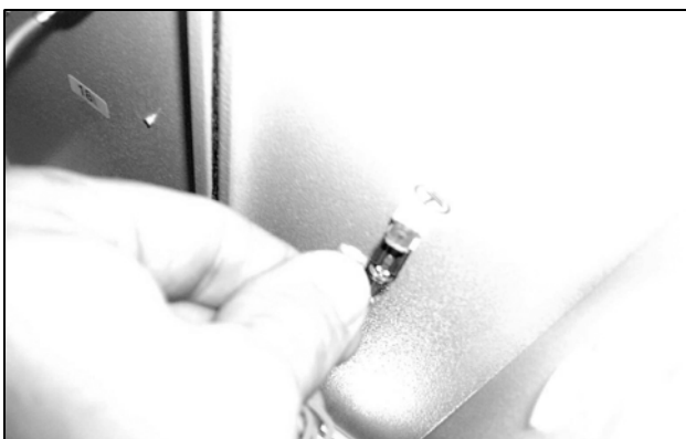
Bild 69: Dra ut fläktens jordkabel (2)
