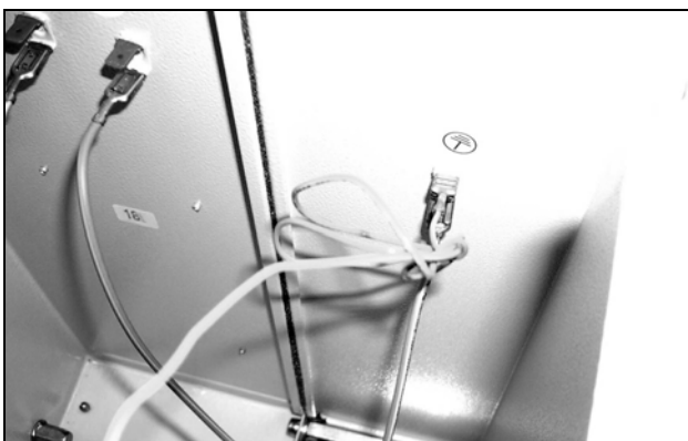
Bild 68: Dra ut fläktens jordkabel (1)
