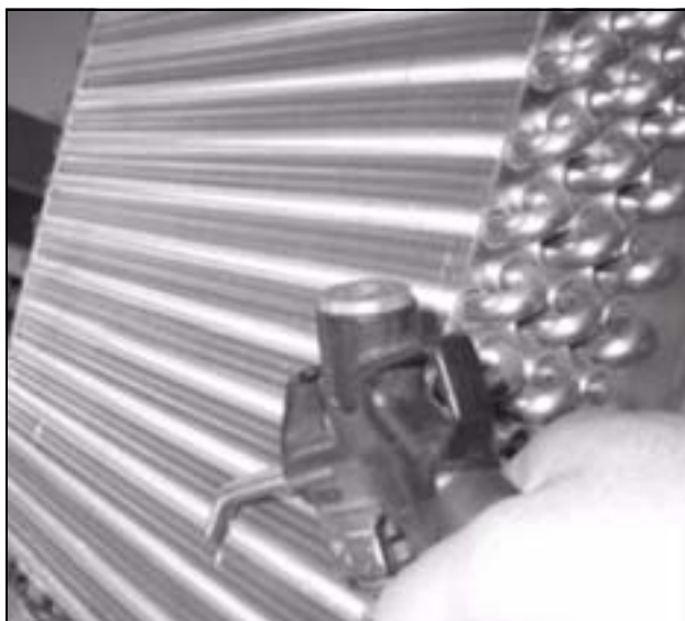
Obr. 40: Registr výměníku tepla a prostor kompresoru vyfoukat stlačeným vzduchem
