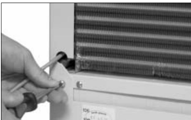
Imagen 36: Extraer los tornillos de fijación de la cubierta (extraer cuatro tornillos)
