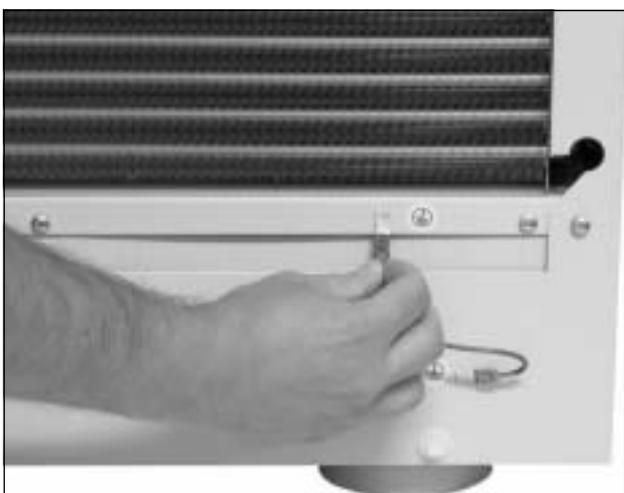
Imagen 35: Desconectar el cable de puesta a tierra
