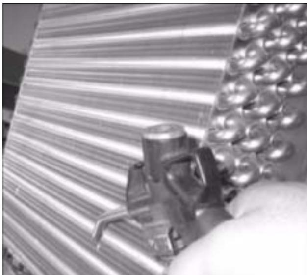
Imagen 40: Aplicar aire a presión en el registro del intercambiador de calor y el espacio del compresor
