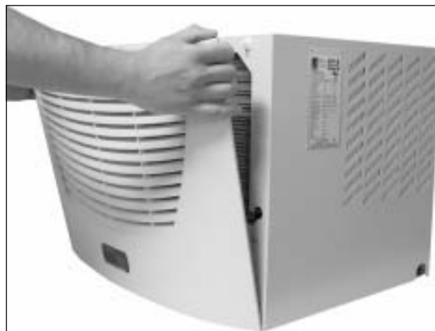
Kuva 32: Irrota lamellisäleikkö
