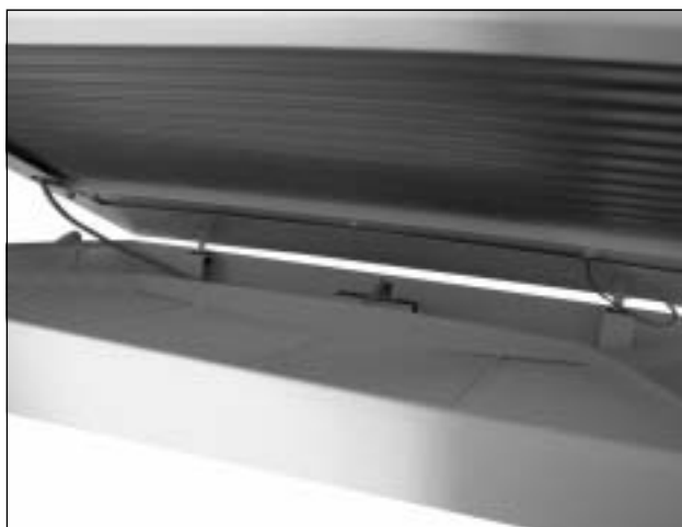
Kuva 41: Asenna lamellisäleikkö
