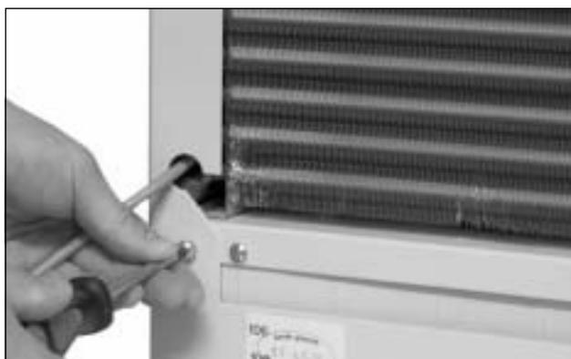
Fig. 36: Svitare e togliere le quattro viti di fissaggio della cuffia di copertura
