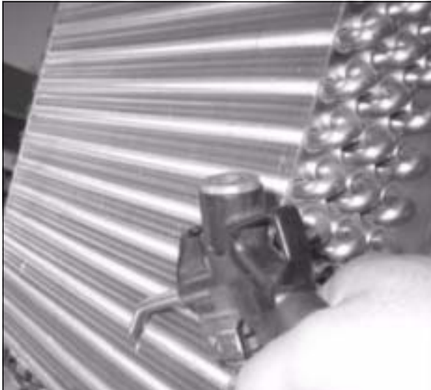
Afb. 40: Warmtewisselaarregister en compressoruimte met perslucht doorblazen
