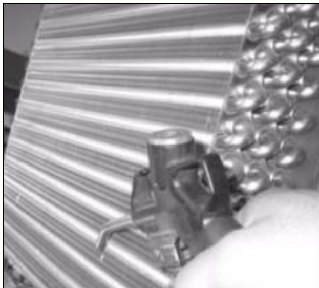
Bild 40: Rengör värmeväxelpaketet och kompressorum med tryckluft
