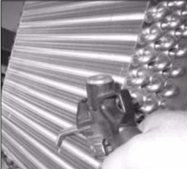
Рис. 40: Продувка теплообменного элемента и компрессорного отделения сжатым воздухом
