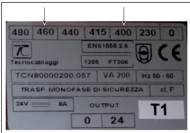
Imagen 9: Conexión transformador
