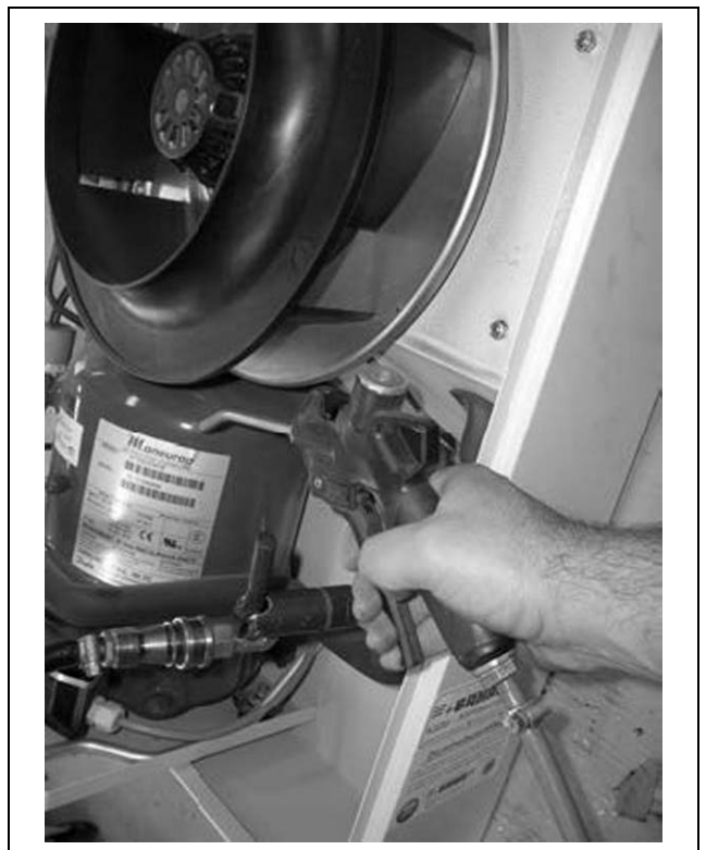
Fig. 28: Wärmetauschregister und Kompressorraum mit Druckluft ausblasen
