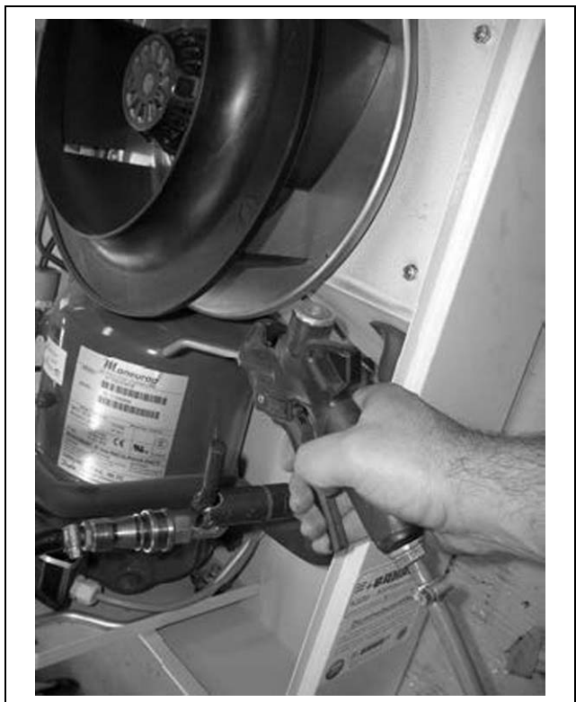
Fig. 28 : nettoyer l'unité d'échange thermique et l'espace compresseur à l'air comprimé
