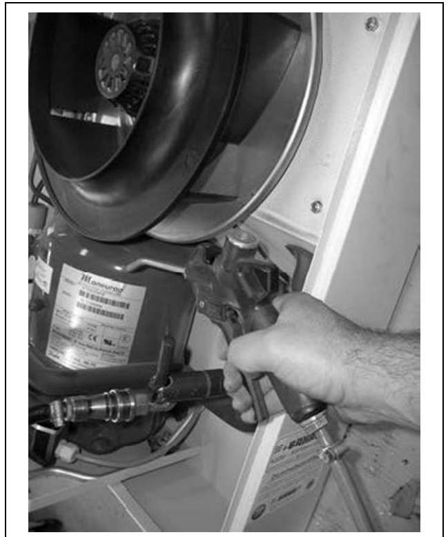
Fig. 28: Aplicar aire a presión en el registro del intercambiador de calor y el espacio del compresor
