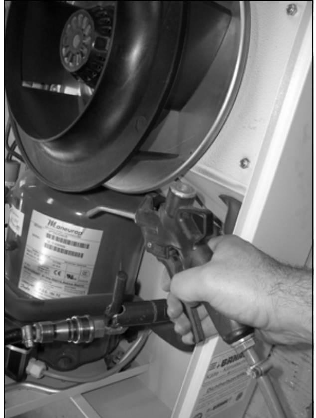
Imagen 52: Aplicar aire a presión en el registro del intercambiador de calor y el espacio del compresor (2)
