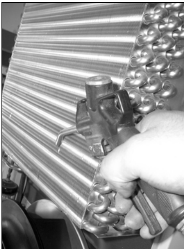
Afb. 51: Warmtewisselaarregister en compressoruimte met perslucht doorblazen (1)
