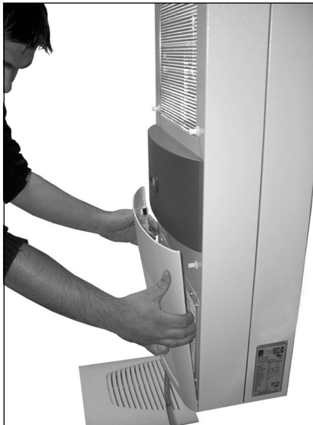
Afb. 36: Onderste ventilatierooster verwijderen
