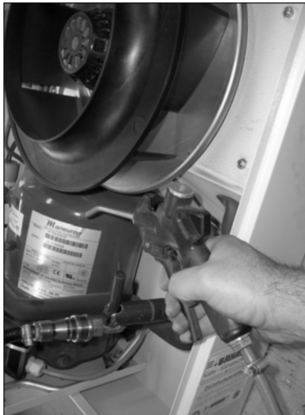
Afb. 52: Warmtewisselaarregister en compressoruimte met perslucht doorblazen (2)
