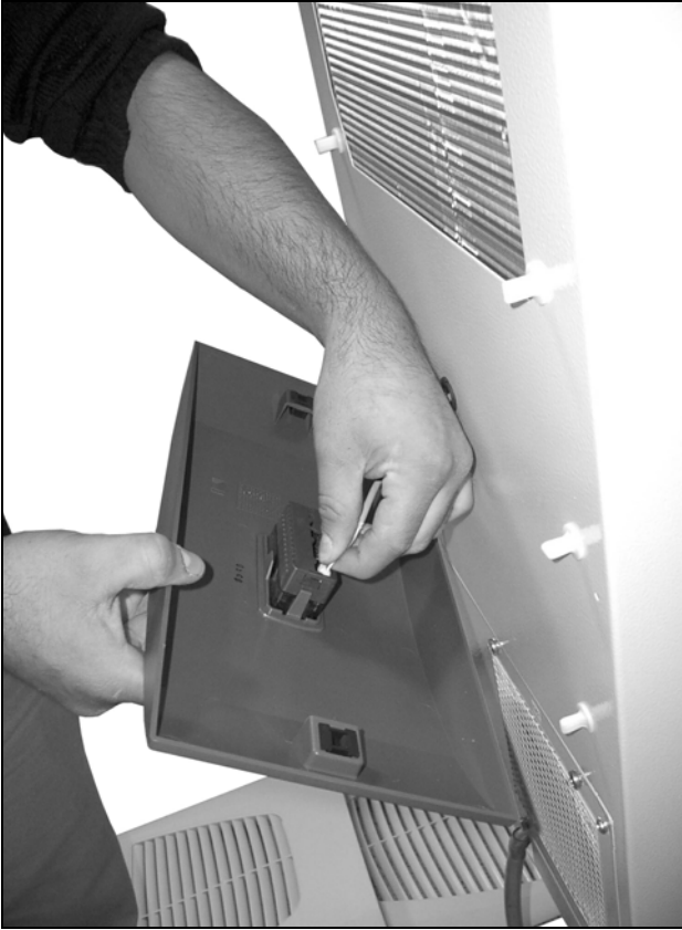
Afb. 38: Steker van het display losnemen (1)
