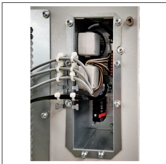
Rys. 33: Punkt montażu rdzenia ferrytowych przy SK 3486330, SK 3487330, SK 3488340, SK 3489340
