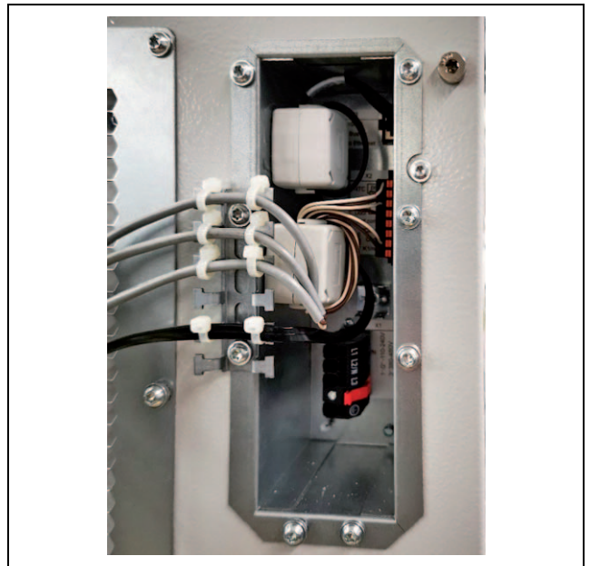
Obr. 33: Upevňovací bod pro feritové jádro na SK 3486330, SK 3487330, SK 3488340, SK 3489340
