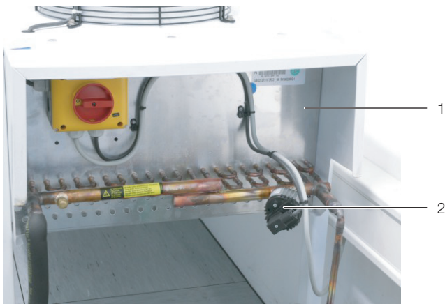
Abb. 29: Druckschalter am Verflüssiger
