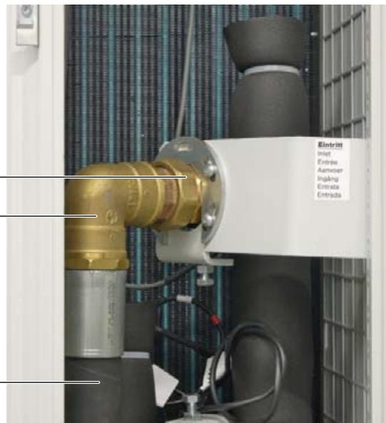
Abb. 47: Schlauchanschlusskit
