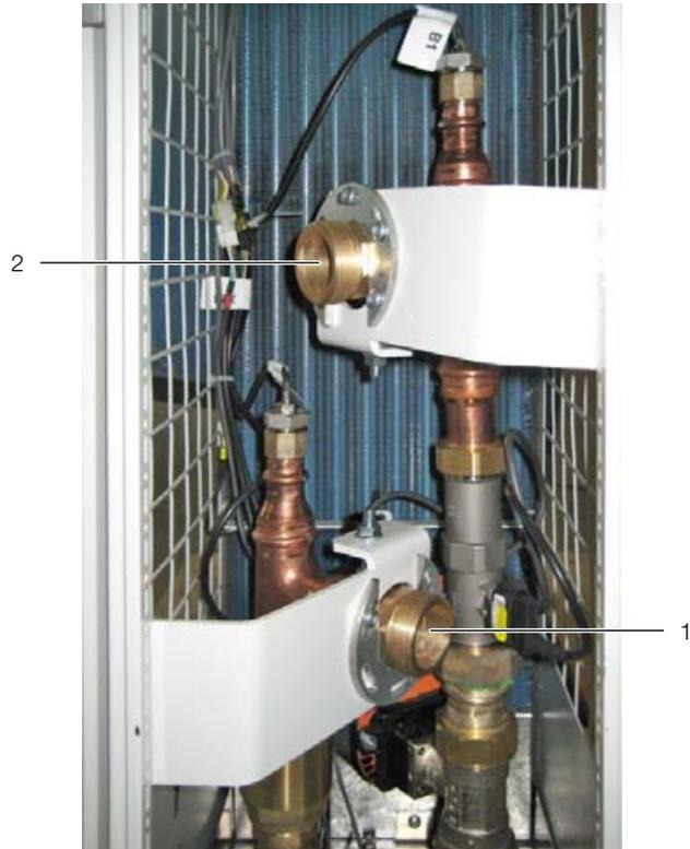
Abb. 46: Kaltwassernetz-Anschluss
