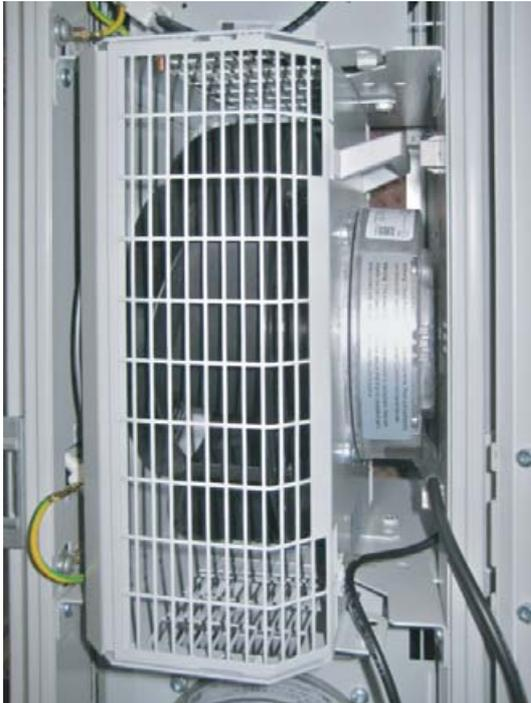
Abb. 31: Gedrehtes Lüftermodul im Lüftereinschub – Ausführung LCP Inline und LCP Rack
