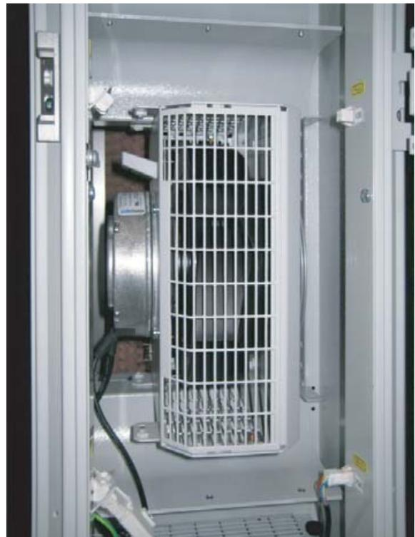
Abb. 33: Gedrehtes Lüftermodul im Lüftereinschub – Ausführung LCP Inline flush
