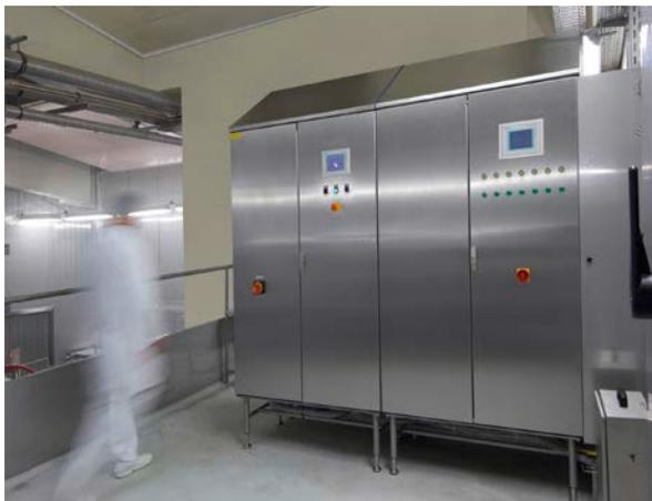
Abbildung 3: Das Rittal TS 8 Anreiherschrank-System aus rostfreiem Stahl kommt in der Nahrungsmittelindustrie zahlreich zum Einsatz.
