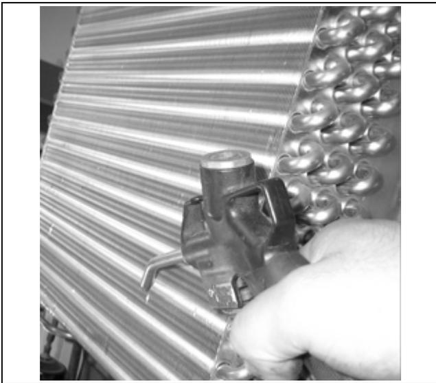
Imagen 47: Limpieza del condensador
