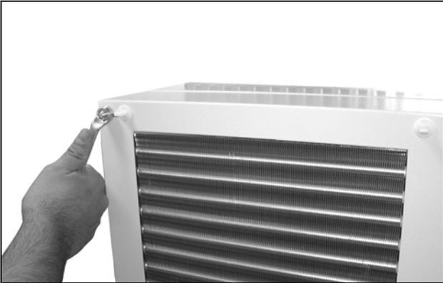
Fig. 44 : Démontez le capot (4 écrous à dévisser)
