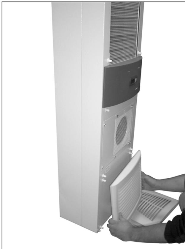
Fig. 58 : Retirer la grille à lamelles inférieure (2)
