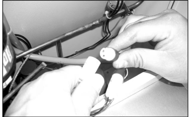
Fig. 67 : Débrancher les fiches de raccordement du ventilateur (3)
