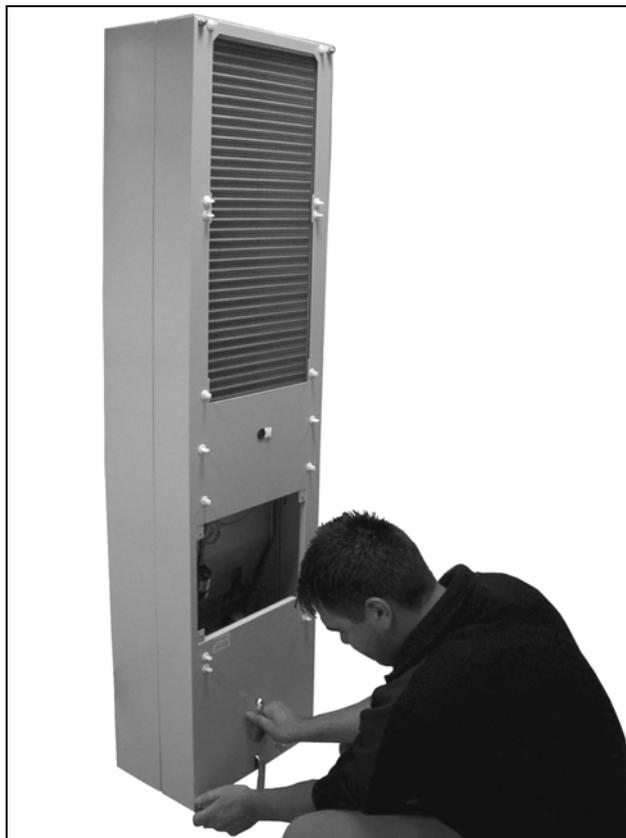
Fig. 70 : Dévisser les 4 écrous du capot
