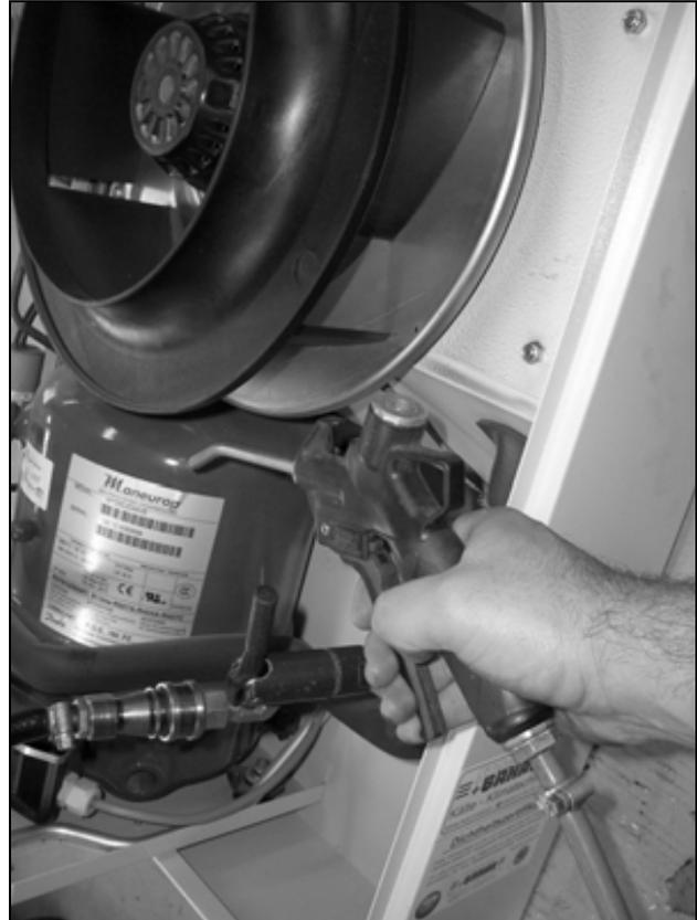
Fig. 76 : Nettoyer l'unité d'échange thermique et l'espace compresseur à l'air comprimé (3)
