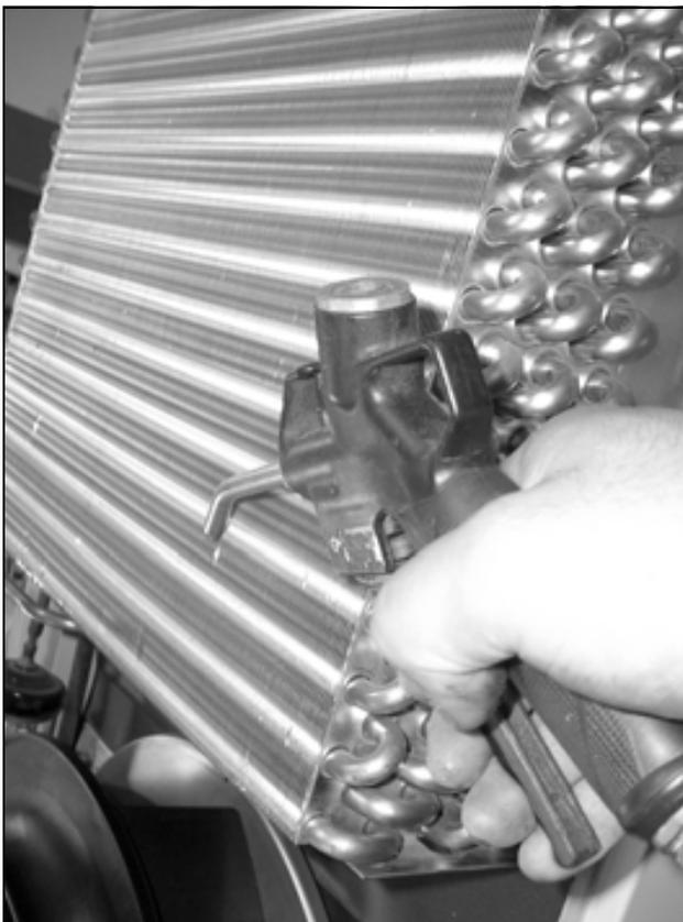
Fig. 75 : Nettoyer l'unité d'échange thermique et l'espace compresseur à l'air comprimé (2)
