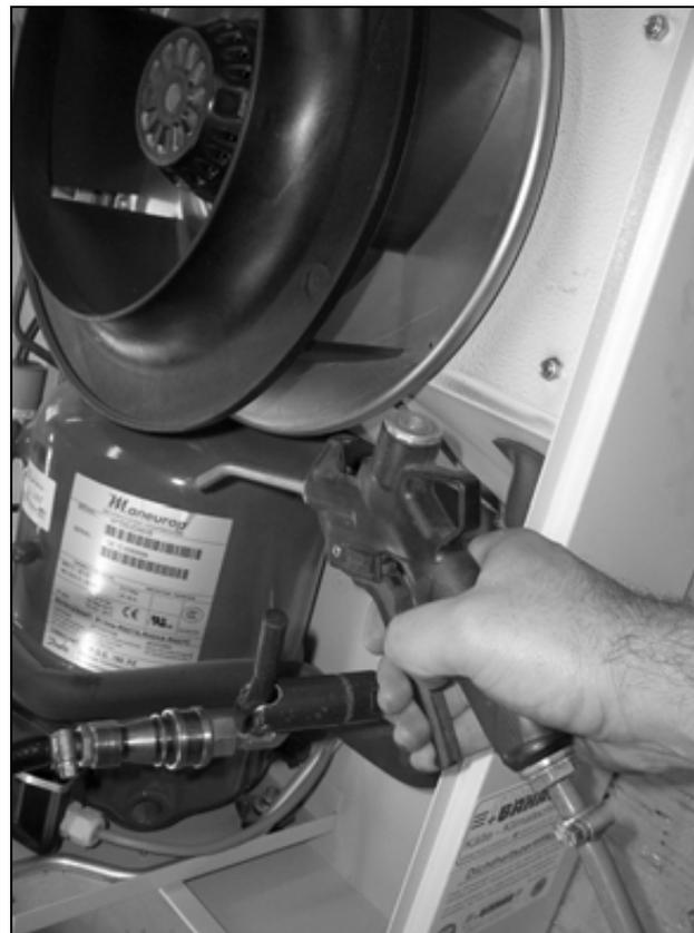
Fig. 52 : Nettoyer l'unité d'échange thermique et l'espace compresseur à l'air comprimé (2)
