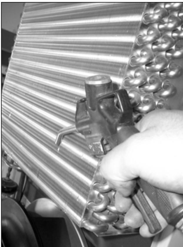
Fig. 51 : Nettoyer l'unité d'échange thermique et l'espace compresseur à l'air comprimé (1)
